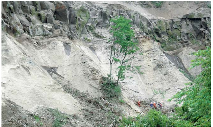
写真 岩手・宮城内陸地震によるがけ崩れ救助地点の状況 活動地点上方にある急な部分の転倒が懸念された。
